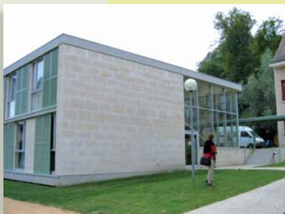
1 Maison de retraite à Presles (95), 2004. Salle de 240 m 2 rafraîchie par un « puits canadien » (entreprise Canada Clim)
